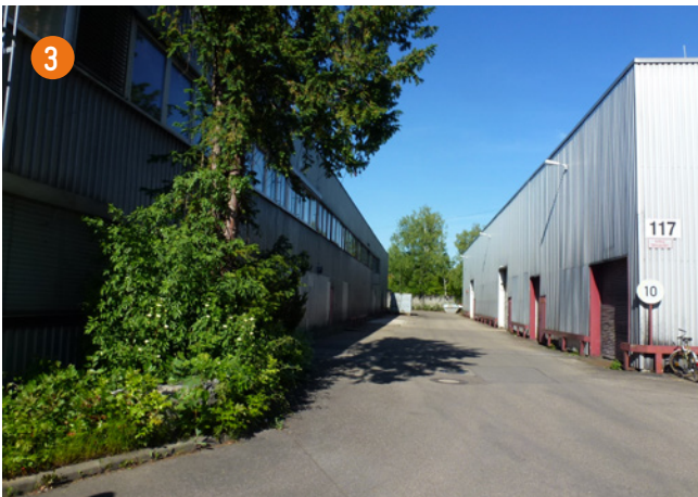
3 Durchfahrt zum hintern Bereich, Blickrichtung Bahndamm
