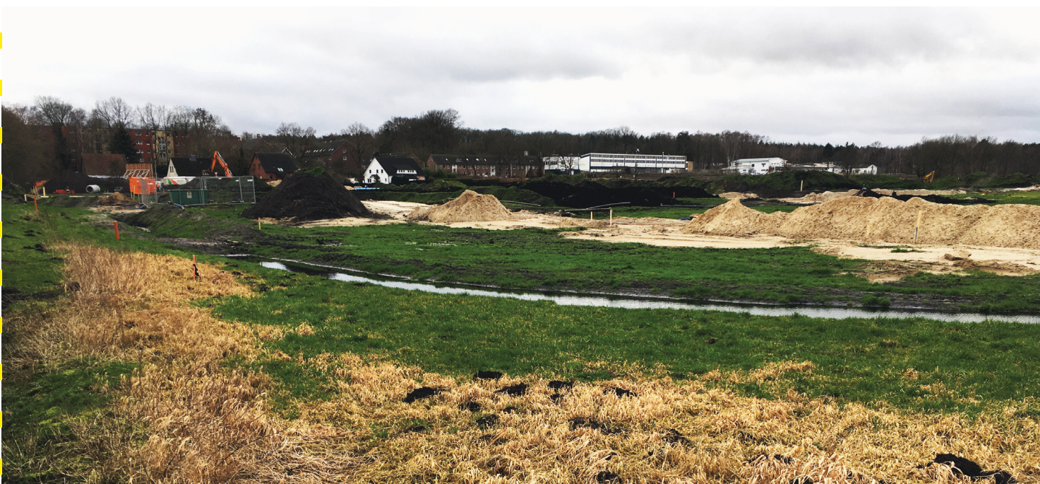
Abb. 8: Blick in Richtung Süden auf das Neubaugebiet, Beginn der Erschließungsarbeiten
